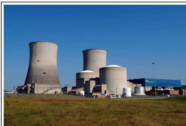
Elektrárna Watts Bar-1
