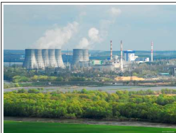
Novovoronežská jaderná elektrárna 1
